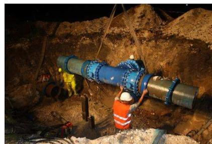
Raccordement de nuit sur réseau dn 500 mm
